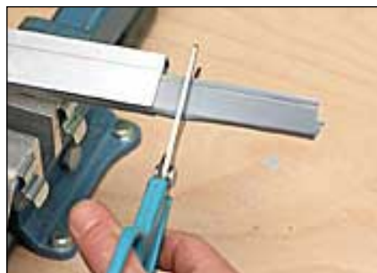
8 Dichtprofil mit Überstand abschneiden
