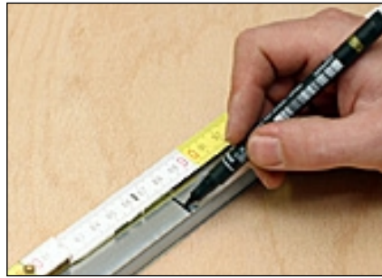
2 Kürzungsseite: Seite ohne Auslöser Schnittstelle anzeichnen
