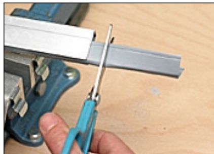
8 Dichtprofil mit Überstand abschneiden
